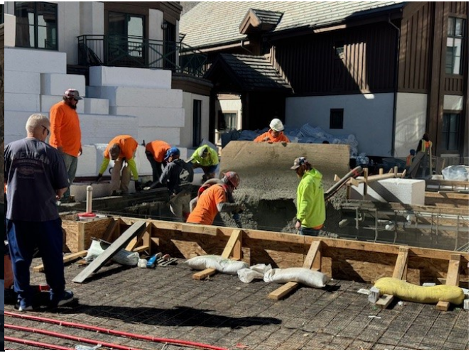
Pouring Hot Tub Shell
